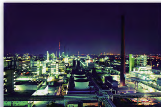
Industriepark Höchst, Frankfurt, Germany
